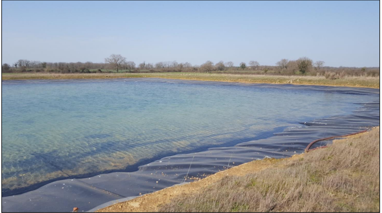
Photo de la réserve d'eau incendie de 2000m 3
